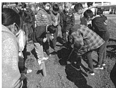
埋設物の掘り出し
