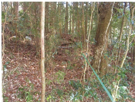
(機能強化)作業道開設 中間点
