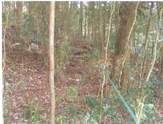
(機能強化)作業道開設 中間点
